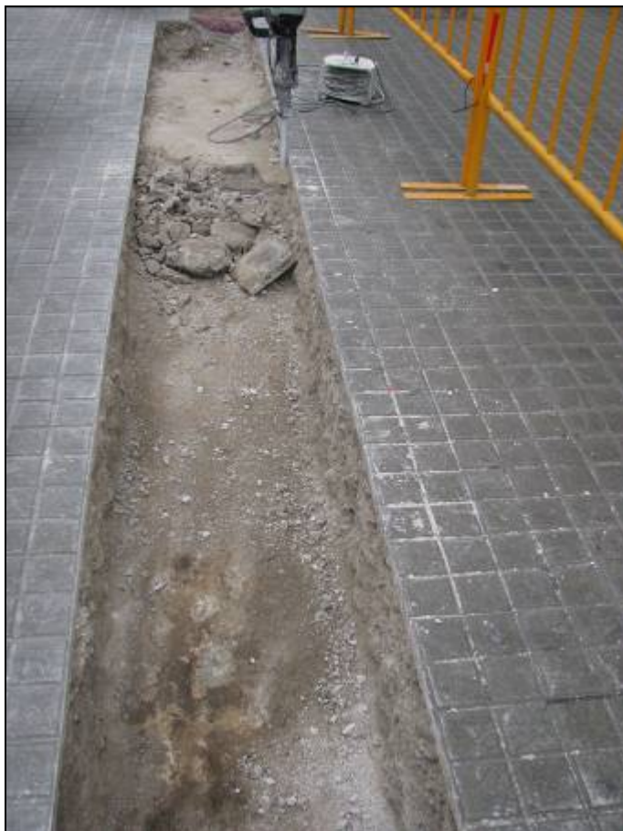
Solera de formigó que apareixia al llarg de la rasa.
