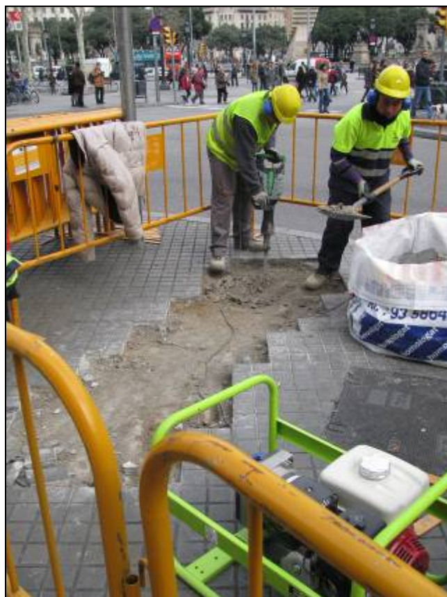
Inici de l'obertura del primer tram de rasa.
