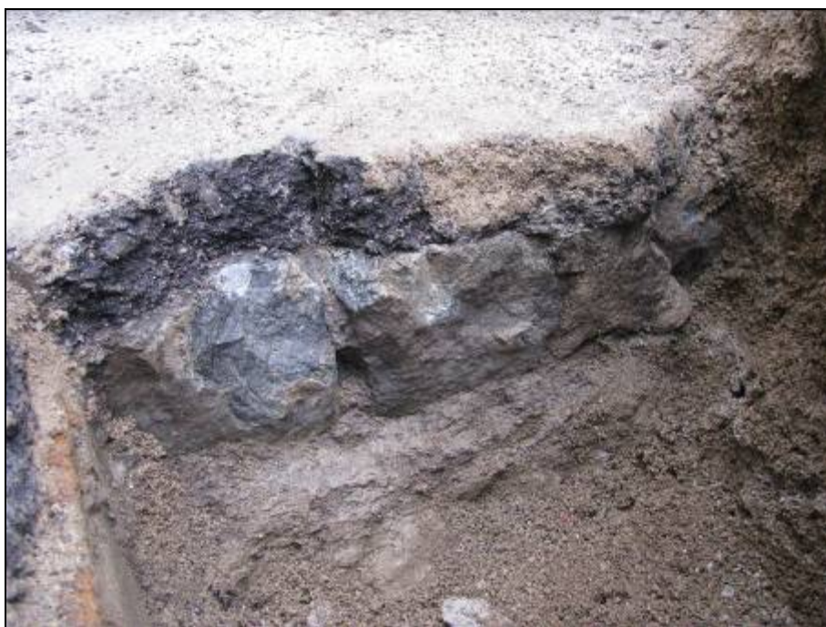
Detall de la successió de paviments; asfalt i llambordes.
