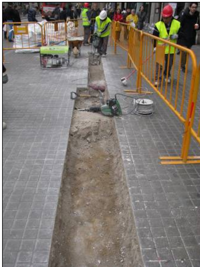
Obertura de la rasa.
