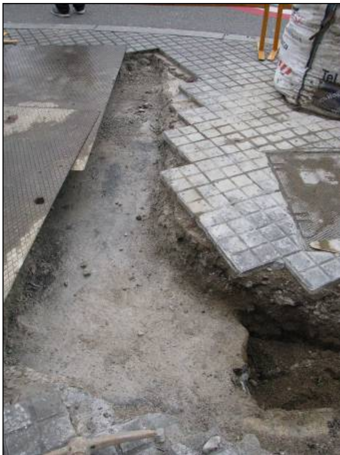
Paviment d'asfalt sota el nivell actual.
