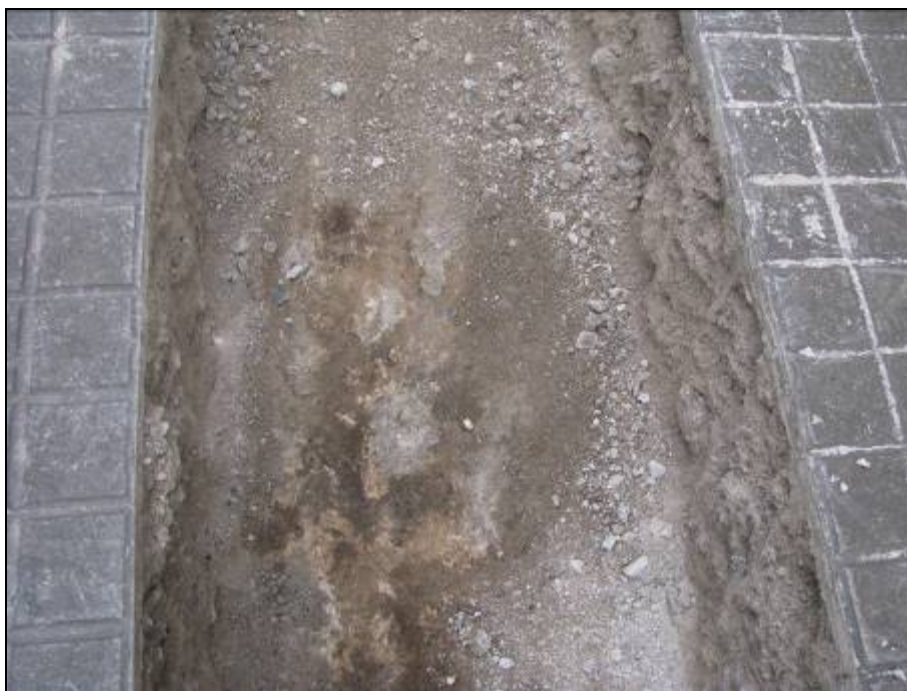
Detall de la solera de formigó que apareixia al llarg de la rasa.
