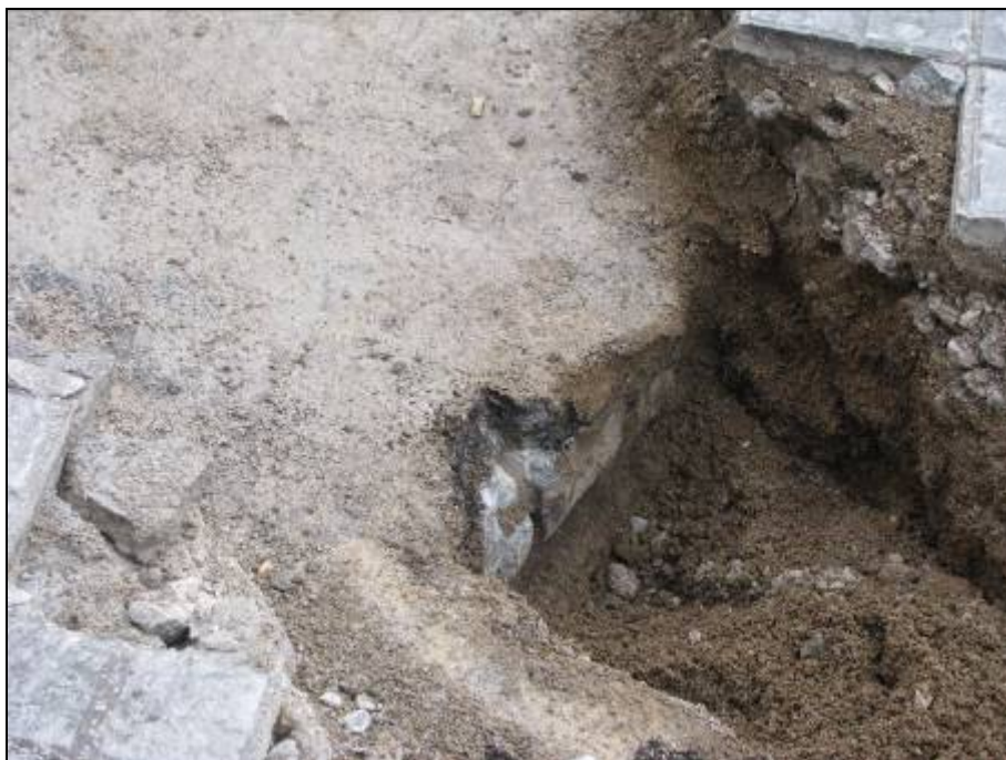
Paviment de llambordes sota el d'asfalt.
